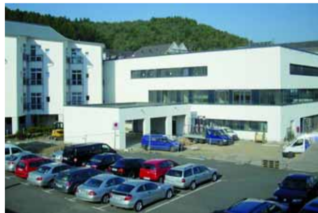
Im Umbau: Bettenhaus und neuer Funktionstrakt in Siegen
